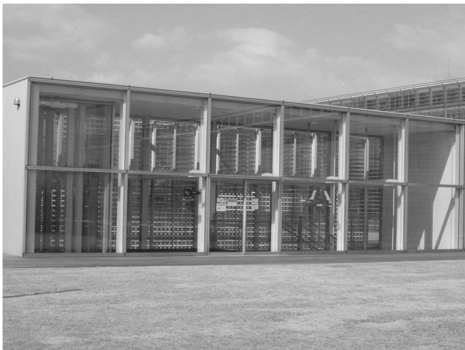
情報センター（図書館）入口
