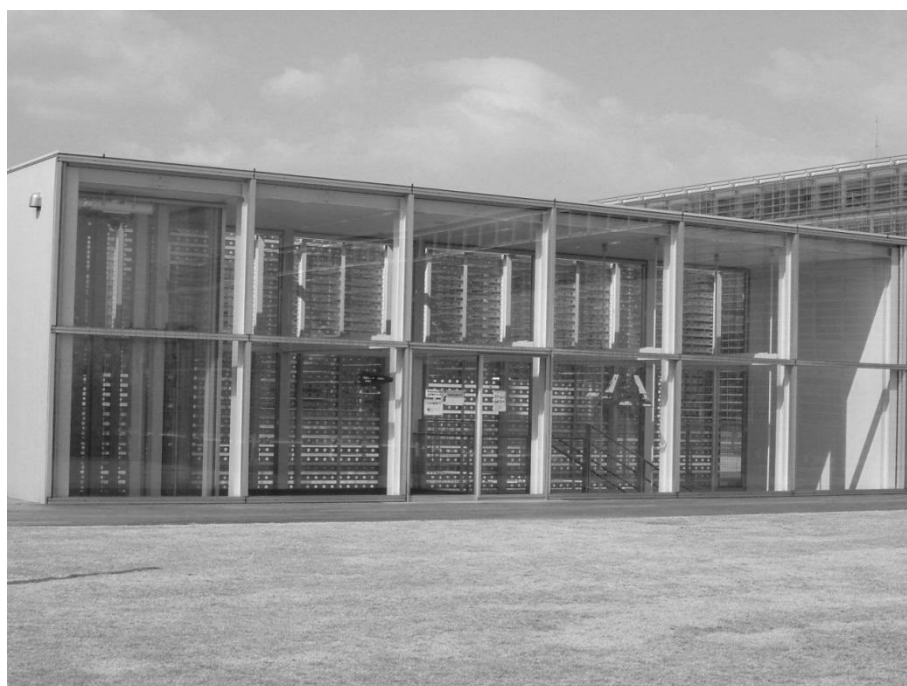
情報センター（図書館）入口
