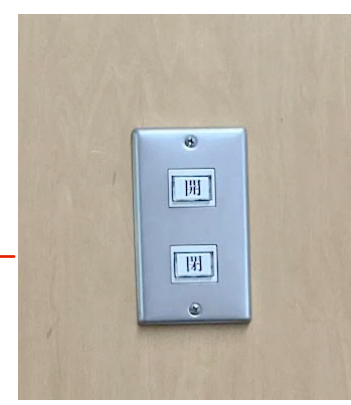
既存 天井面 天窓遮光電動ブラインドスイッチ スイッチ及びフェイスプレート交換
