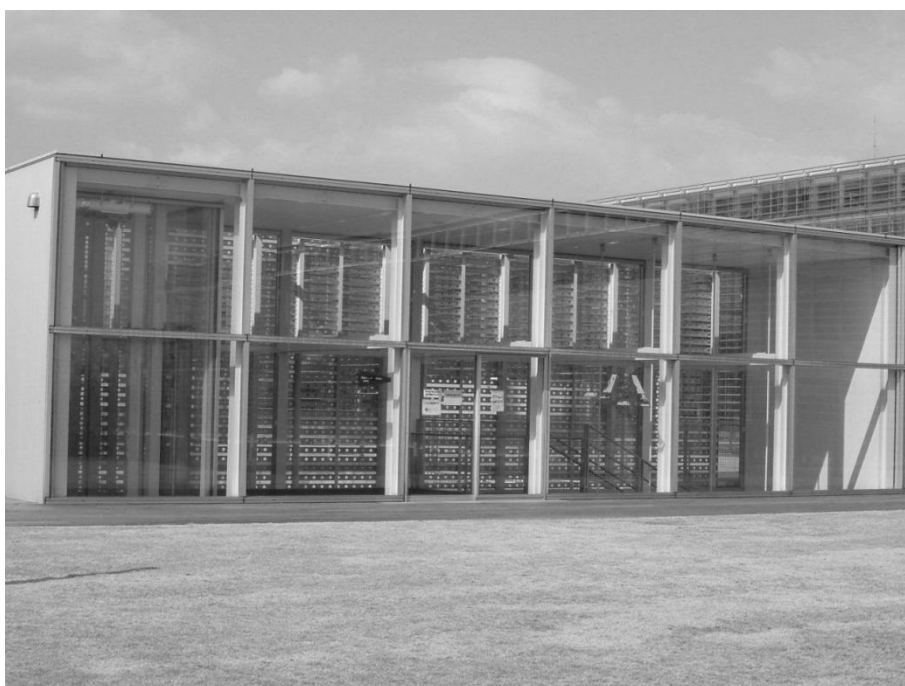
情報センター（図書館）入口
