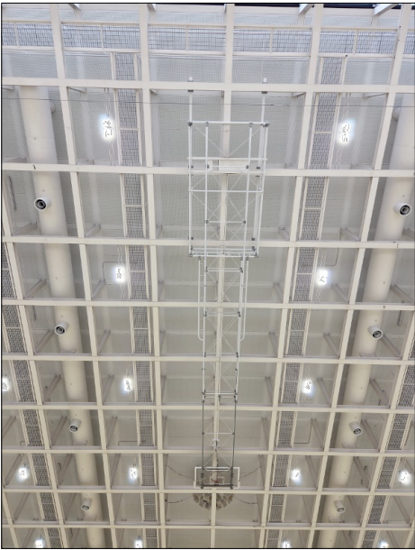
天井トラスの状況(中央)
