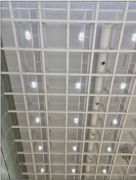
天井トラスの状況(東側)
