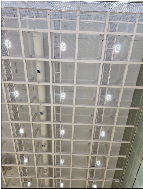
天井トラスの状況(西側)
